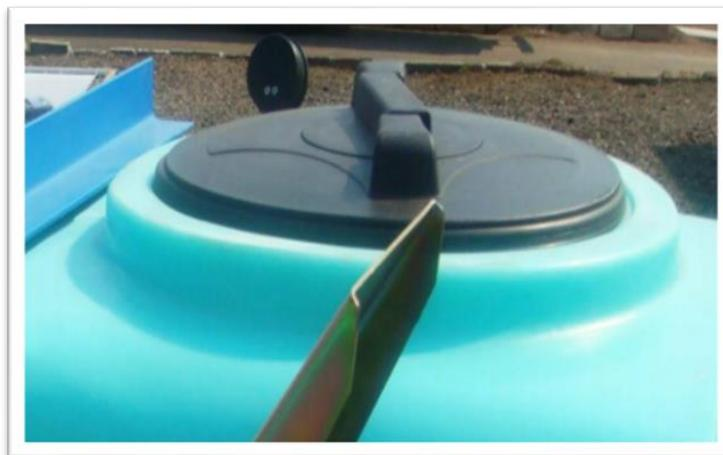
Fig 8: La tapa superior del tanque se encuentra limpia, sin presencia de fugas.
