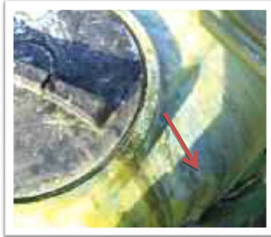
Fig 7: Se observan fugas anteriores ya resacas de la tapa.
